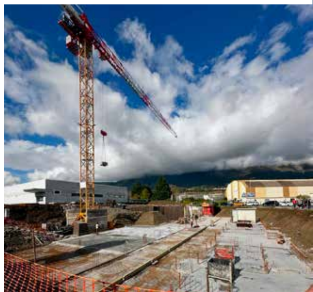
Chantier résidence « Le Triptik » Montbonnot-Saint-Martin - VEFA MV Résidences Architecte : L&L Architecture
